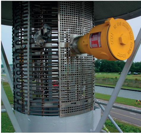
Антиобледенительное устройство на выходе вытяжной трубы, 1кВт (взрывозащита EEx „d” IIC T3).
