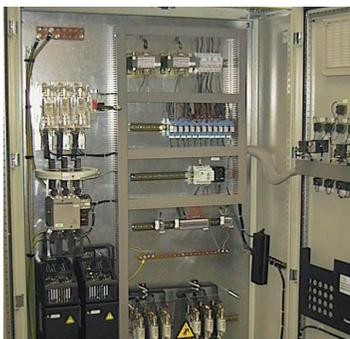
Панель управления мощностью с двумя тиристорами
